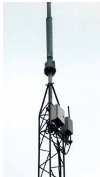
Über LoRaWAN-Antennen wird das Funksignal im ganzen Land verteilt.
